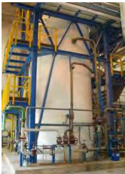
sx. Sistema di depuratore polveri con filtro a maniche e sistema di ricircolo fumi
